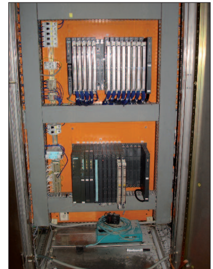
Nachgerüstetes Zentralgerät
