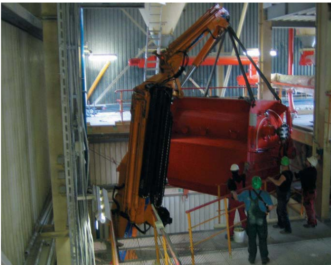
Einheben des Mixers in die vorhandene Anlage
