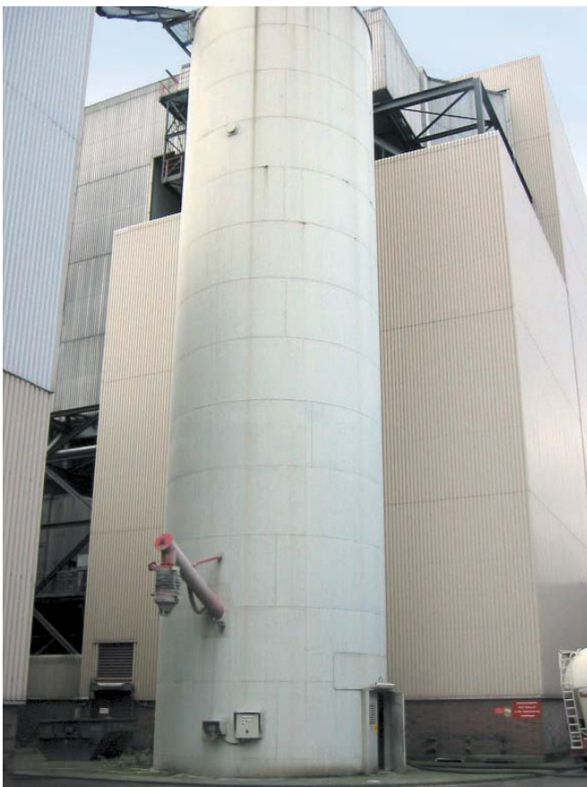
800 m 3 Silo vor dem Versetzen
