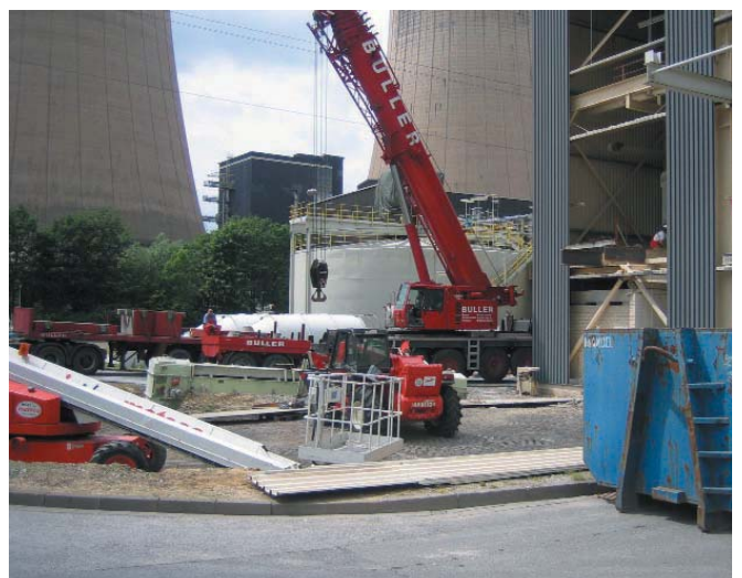
Demontagearbeiten der nicht mehr benötigten Anlagenteile
