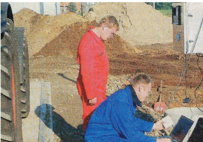
Präzisionsarbeit: Die Fahrzeugwaage am Eingang der Biogasanlage in Hollich wird exakt „eingeregelt“.
